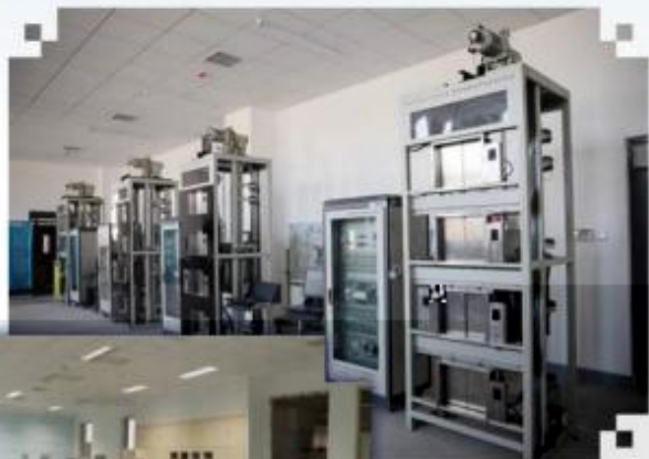
智能电梯安装调试维护训练场所
